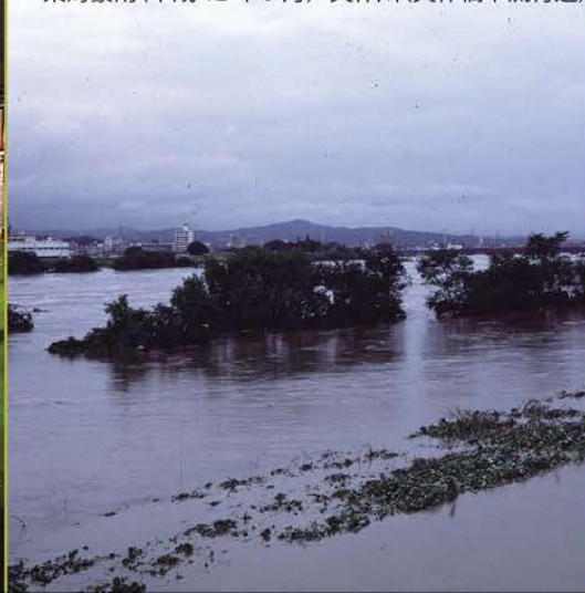
東海豪雨(平成12年9月) 矢作川(矢作橋下流付近)
