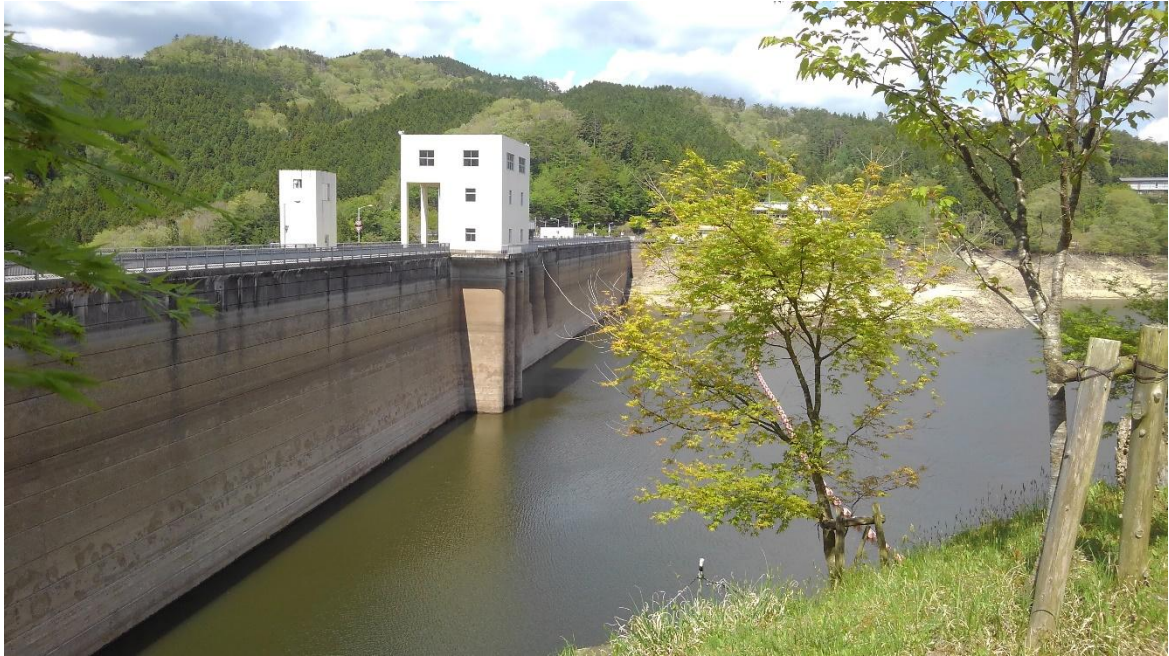
羽布ダム（貯水率 29%） 令和元年 5 月 6 日時点
