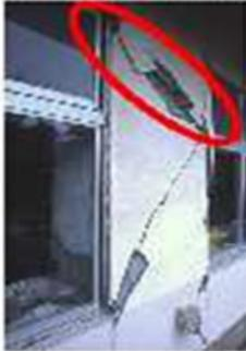
コンクリートの柱に深く入ったひびや、割れ目の大きなひびは損傷が大きい。
