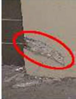
表面のコンクリートのはがれや細かいひびは、損傷が小さい。
