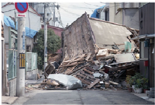
写真 建物の倒壊により 閉塞した道路 出典：神戸市ホームページ
