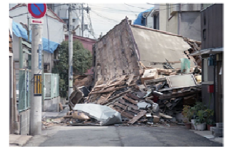
写真 建物の倒壊により 閉塞した道路 出典：神戸市ホームページ
